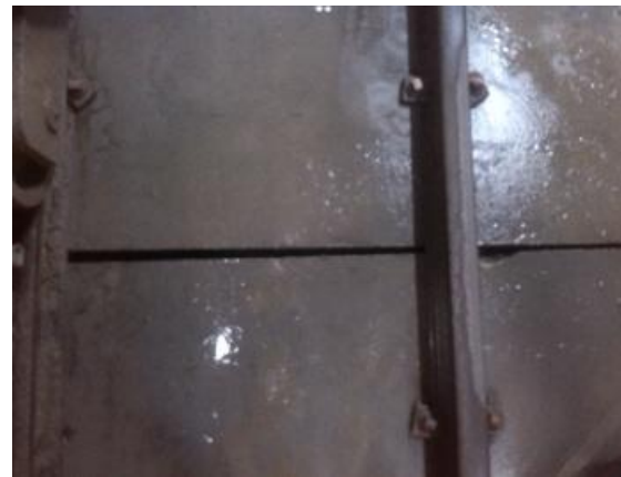
شکل (۱۲). ایجاد فاصله عمده بین سگمنت‌های Invert در سمت بیرونی قوس جهت ایجاد قوس یکنواخت در ریل‌ها
