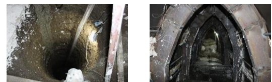
شکل (۹). (الف و ب): اجرای عملیات شمع های اصلی (دسترسی)، (ج): اجرای گالری دسترسی شمع های ثانویه، (د): اجرای شمع های ثانویه
