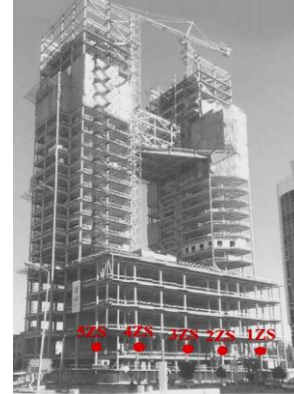
شکل (۷). نمای ساختمان زیبا سازه و محل نصب تیلت مترلها
