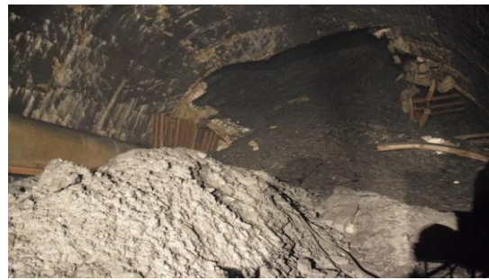
شکل (۱۶). ریزش توده های اسلیتی در تونل خوانسار
