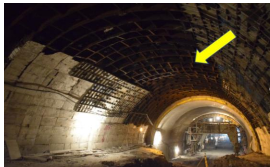
شکل (۱۷). تغییر شکل دادن قاب تونلی به دلیل تنش های روباره ای
