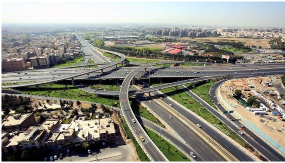
شکل (۳). نمایی از پروژه تقاطع غیر همسطح جناح
