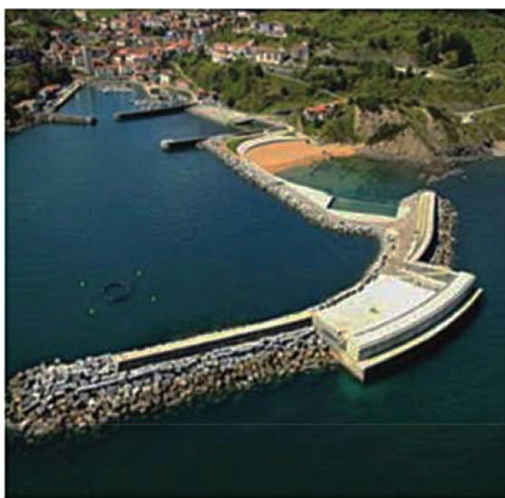
شکل ۱: موج شکن OWC-WEC
