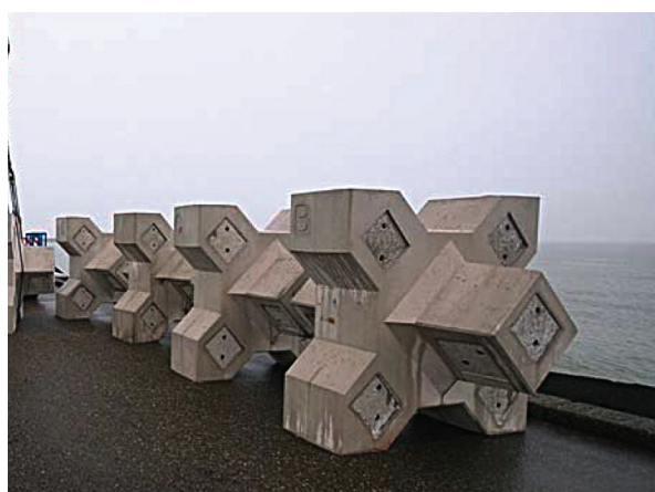
شکل ۱۶: اکوایکس لاک - آرمور سازگار با محیط زیست
